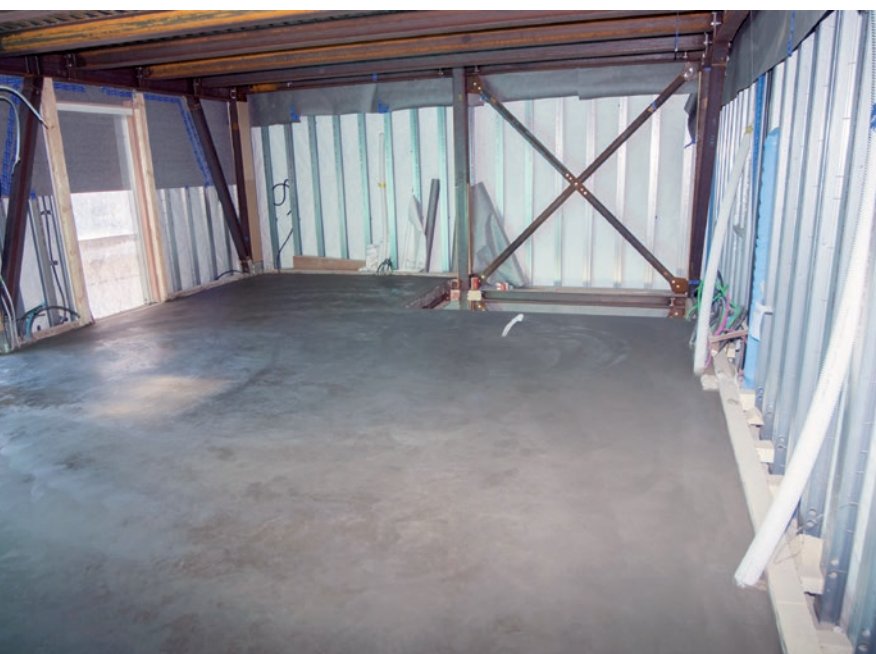
PAVIMENTAZIONE IN CALCESTRUZZO CON CEMENTO POZZOLANICO
