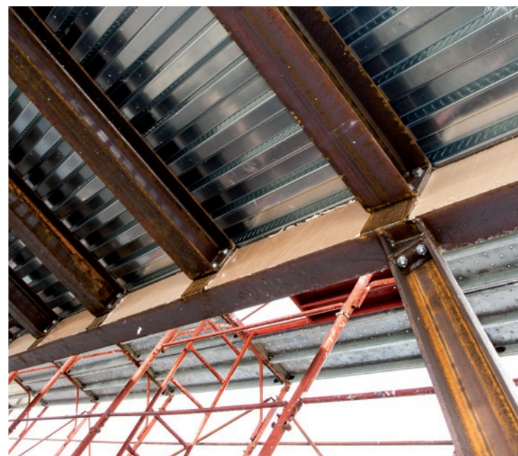
STRUTTURA IN PUTRELLE COIBENTATE
