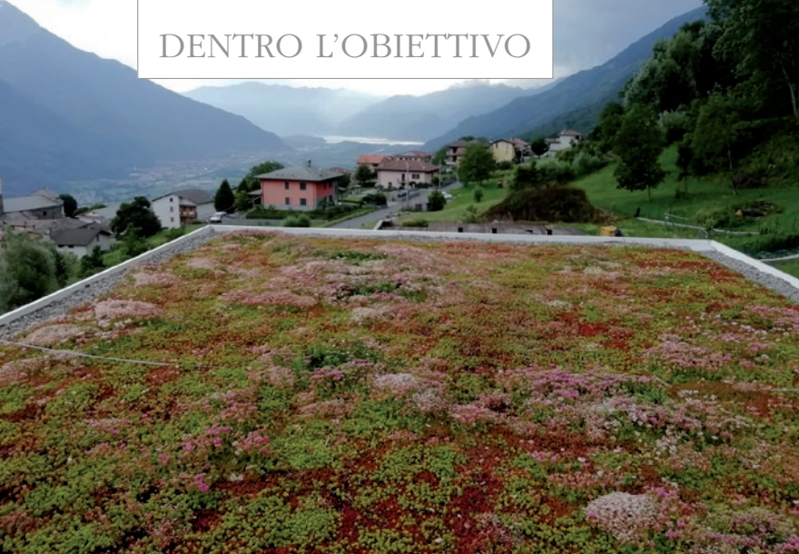
TETTO VERDE ESTENSIVO
