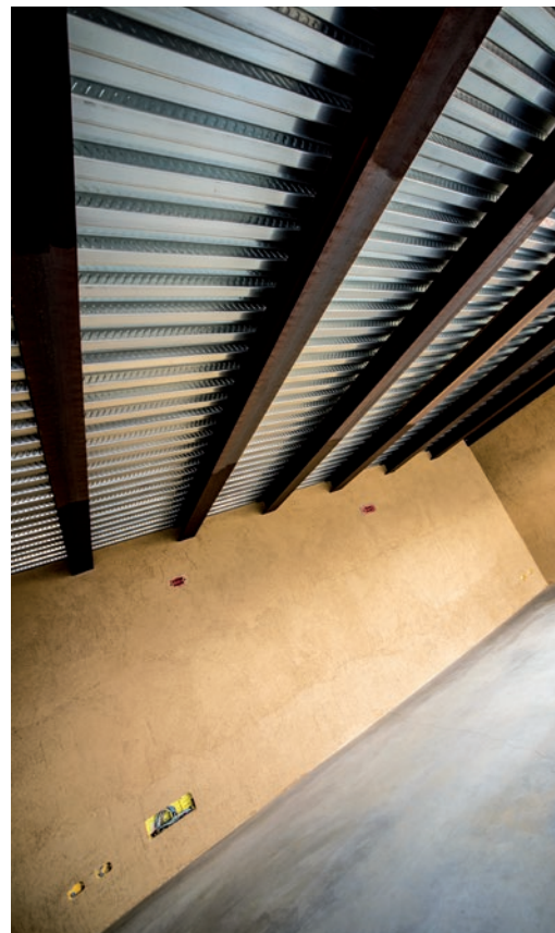
INTONACO E FINITURA IN ARGILLA E RETE IN FIBRE NATURALI DI JUTA
