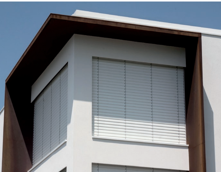
SCHERMATURE SOLARI MOBILI E VELA FISSA IN CORTEN
