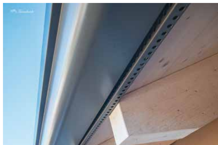
VENTILAZIONE NASCOSTA. Dettaglio
