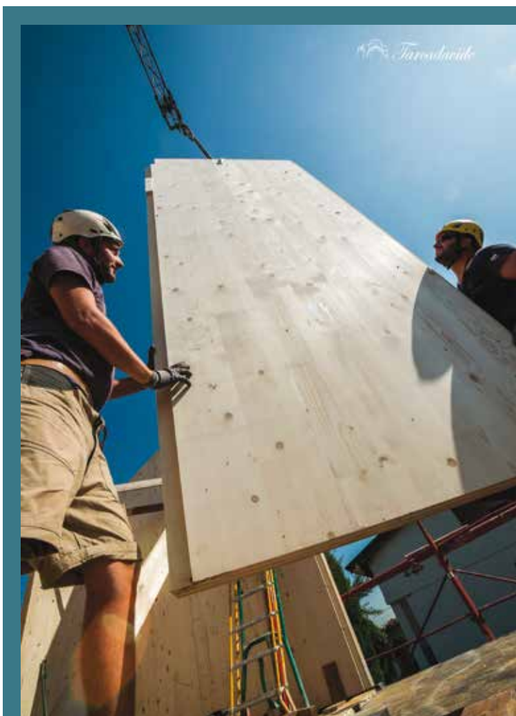
IN CANTIERE. Posa dei pannelli Xlam e del cappotto in fibra di legno
